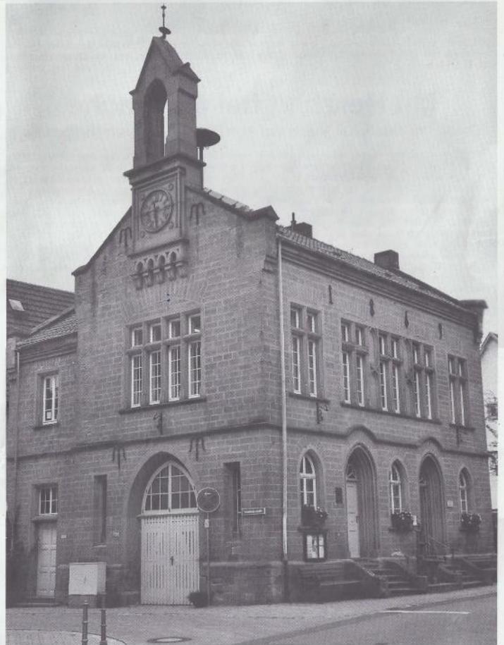
Das energetisch sanierte Alte Rathaus in Richen war und ist ein Vorzeigeprojekt im jetzt abgeschlossenen Dorferneuerungsprozess. Bilder und Text: Dorschel
